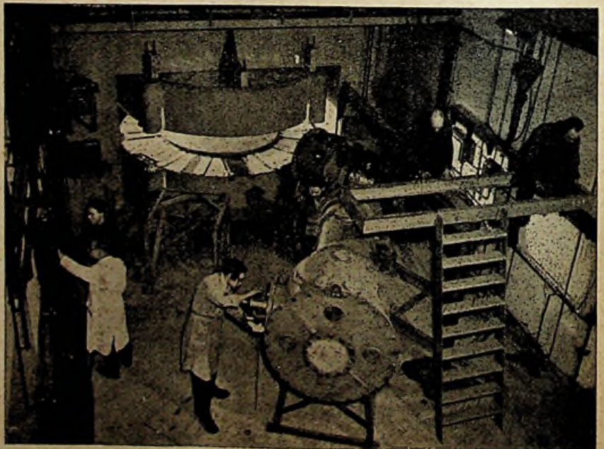
Fig. 2. De magneet van de cyclotron van de andere kant gezien, waar men reeds bezig is met het monteren van nieuwe onderdelen.
